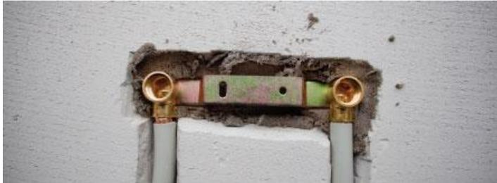
Puis comblez le reste du trou à l'aide d'une truelle ou d'une spatule à enduire avec la résine obtenue.
