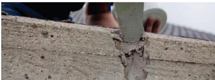
Puis recréez la forme initiale du mur avec le mortier époxy en créant éventuellement un petit coffrage avec une plaque de coffrage.
