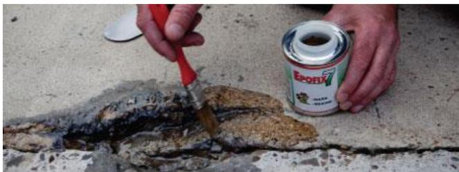
Prenez ensuite un mortier époxy bi-composant pour effectuer la réparation tel le **Floor17** en mélangeant au préalable les 2 composants dans un seau. Attention, la réparation doit se faire sur un béton ou une chape de plus de **21 jours**.
