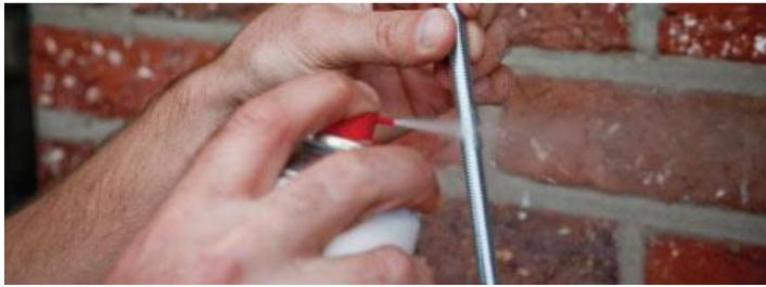
Mettre l'embout de mélange sur la cartouche de scellement chimique. Prendre un pistolet à mastic de bonne qualité et débrayable comme le **Tec7 Gun** qui permette un débit régulier de produit.
