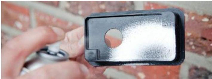
Appliquez un mastic MS polymère avec un tack initial très élevé comme le **X-Tack7** sur toute la périphérie de la partie arrière de l'éclairage avec un pistolet à mastic puissant et débrayable comme le **Tec7 Gun** afin d'avoir un débit régulier.
