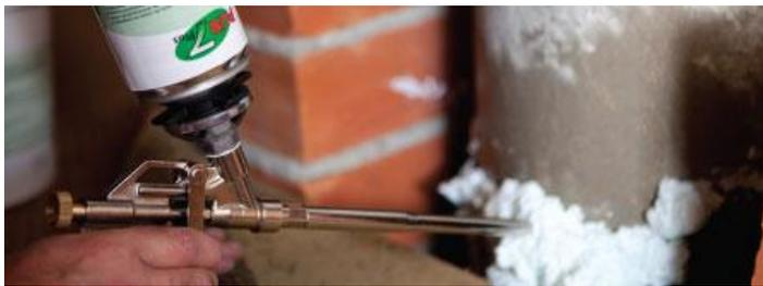
La post-expansion réduite de **Pur7 Plus** permet d'avoir un dosage parfait sans que la mousse ne déborde. Elle permet aussi de n'exercer qu'une faible pression sur les pièces collées (gaines par exemple) et évite leur déformation.
