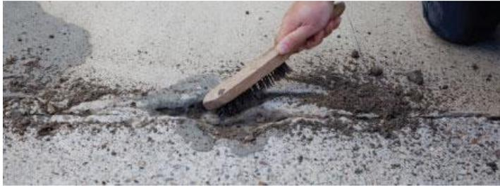
Si la base du support à réparer reste friable et poreuse, vous devez la renforcer en utilisant un agent d'imprégnation et de traitement des surfaces poreuses et fragiles à base de fixateur époxy comme **l'Epofix7**
