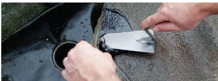
Placer la pièce en caoutchouc décollée ou la pièce de remplacement sur la surface enduite et pressez fortement partout en insistant sur les bords.
