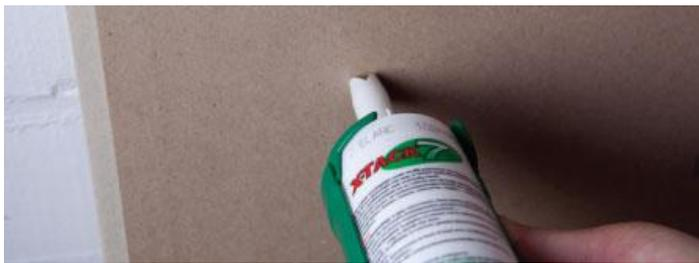
Placez la pointe de l'embout de la cartouche sans la redécouper de façon perpendiculaire à la surface à coller pour obtenir une ligne de collage triangulaire avec une répartition parfaite.
