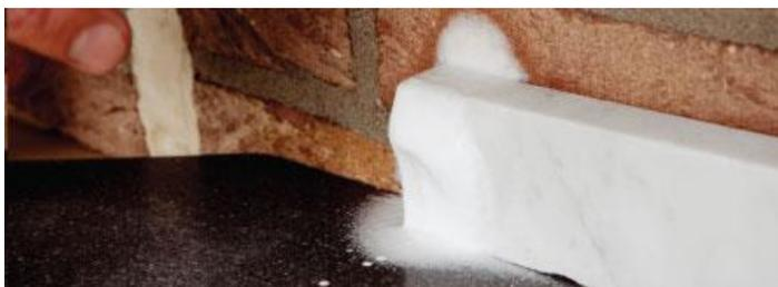
Puis dégraissez la surface avec un nettoyant dégraissant tel que le **Tec7 Cleaner**. C'est la condition préalable afin d'assurer une bonne adhérence permanente du mastic. Vous pouvez aussi utiliser la mousse nettoyante **Foam7** que vous étalerez et nettoierez avec un chiffon sec.
