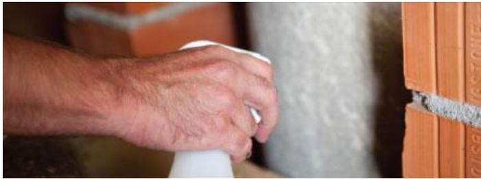
Agitez fortement la bombe de mousse polyuréthane. De préférence utilisez une mousse de montage de classe de feu B1 comme la mousse polyuréthane **Pur7 Plus**. C'est une mousse selon la norme 4102 qui est difficilement inflammable.
