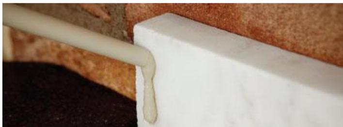
Placez les deux morceaux de pierre à coller de façon perpendiculaire et presser fortement quelques secondes. Ensuite les éléments peuvent être maintenus sans aucune pression.
