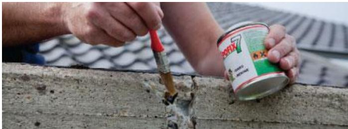
Prenez ensuite un mortier époxy bi-composant pour effectuer la réparation tel le **Wall7** en mélangeant au préalable les 2 composants dans un seau.
