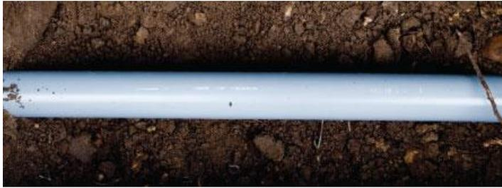
Pour obtenir une meilleure adhérence de la mousse polyuréthane sur le tuyau, humidifiez-le avec un vaporisateur d'eau. De cette façon vous réduirez également le temps de durcissement.
